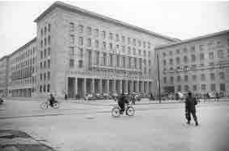
Das ehemalige Reichsluftfahrtministerium an der Leipziger Straße, um 1950
