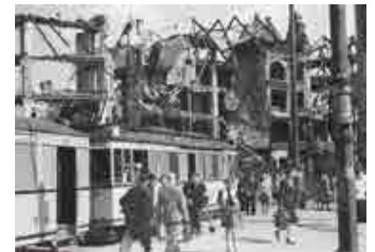
Trümmer am Alexanderplatz 14
