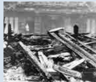
Der ausgebrannte Plenarsaal im Reichstagsgebäude am 28. Februar 1933
