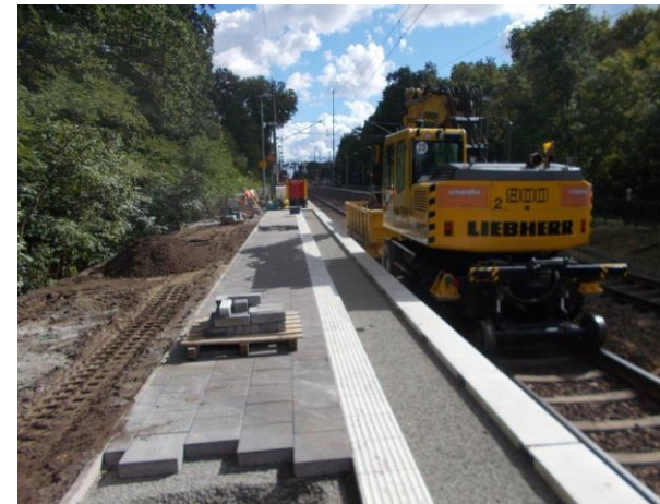
Bauliche Umsetzung der Bahnsteigverlängerungen auf der RE1
