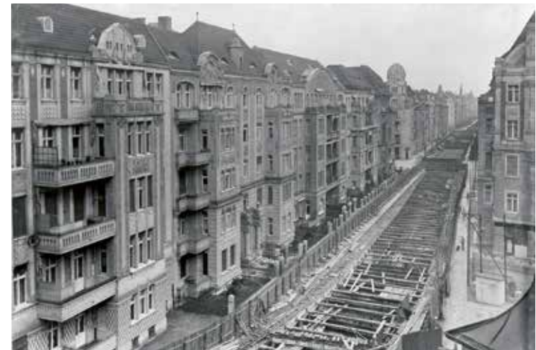
Barbarossastraße: Bau der U-Bahnlinie 4, 1909
